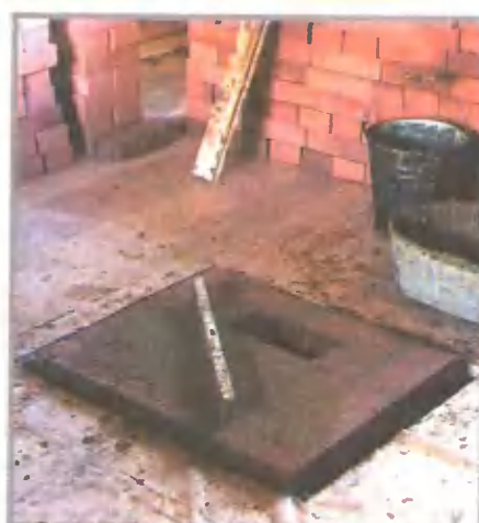
Промежуточный этап работы. Дымоход «Шведки» выведен над полом мансарды
