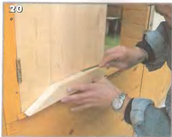
20. Прежде чем перенести контур накладки на полуфабрикат, убедитесь, что щит сплочен без зазоров. При необходимости временно зафиксируйте сборку гайками
