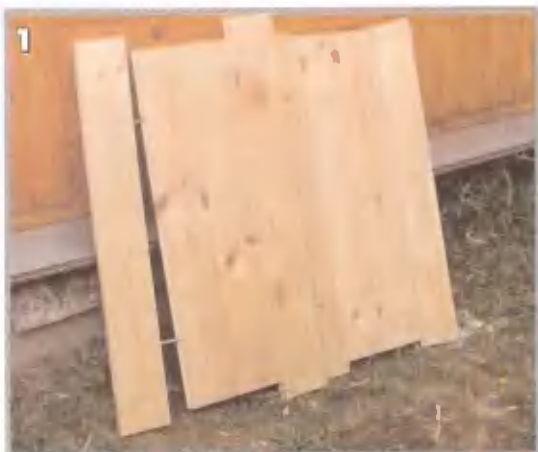
1. Полуфабрикаты щитов — «нанизанные» на шпильки доски, которые отрезаны с небольшим припуском по длине. Ширина каждого щита чуть превышает половину ширины перекрываемого проема
