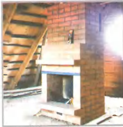
Проверка тяги камина после просушки кладки
