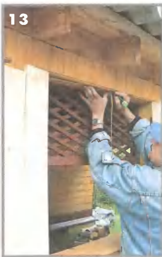
13, 14, 15. Чтобы обеспечить точное сопряжение створок, придется уменьшить щиты по ширине. Для этого найдите средние точки проема (вверху и внизу), перенесите их на заготовки, а затем обрежьте лишние фрагменты
