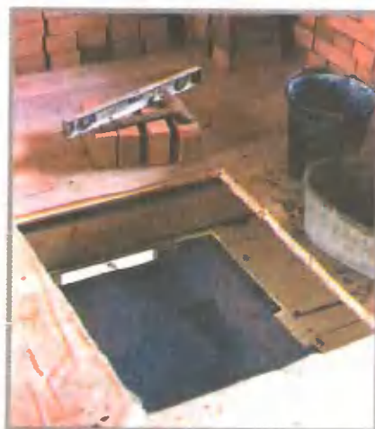
Над дымоходом, возведенным под перекрытие «Шведки», на полу мансарды был размечен проем
