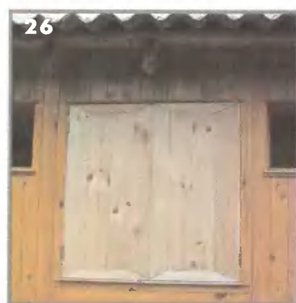
26. Обе створки точно вписаны в проем. Остается скрепить углы, подстрогать, отшкурить, нанести защитные покрытия, установить нащельники, шпингалеты и ручки. Для этого щиты целесообразно снять
