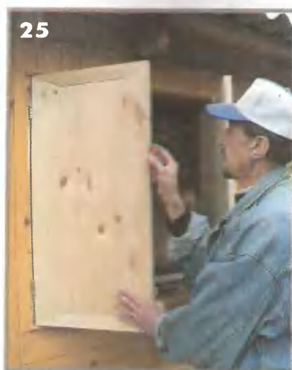
24, 25. Снова повесьте створку и приступайте к доработке второго полуфабриката. При необходимости подстрогайте по месту сопрягаемые торцы щитов
