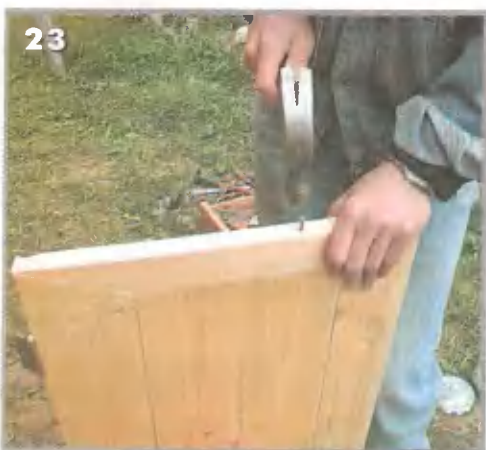
23. Прибейте накладку к торцам средних досок щита. Окончательное скрепление углов «на ус» можно сделать позднее
