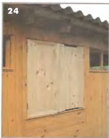
24, 25. Снова повесьте створку и приступайте к доработке второго полуфабриката. При необходимости подстрогайте по месту сопрягаемые торцы щитов
