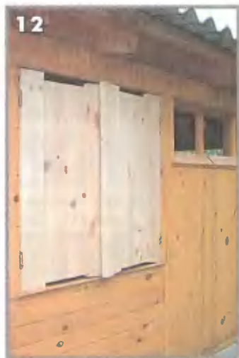
12. Контуры обоих полуфабрикатов «вписаны» в проем с переклестом створок
