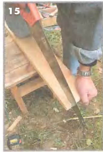
13, 14, 15. Чтобы обеспечить точное сопряжение створок, придется уменьшить щиты по ширине. Для этого найдите средние точки проема (вверху и внизу), перенесите их на заготовки, а затем обрежьте лишние фрагменты
