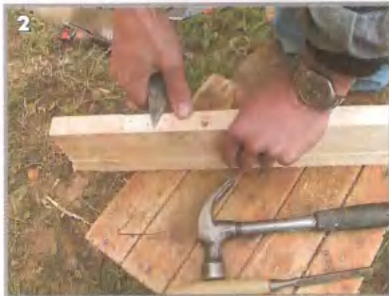
2,3,4. Чтобы установить петли и разделить отверстия под стопорные гайки, целесообразно отделить от щитов крайние детали
