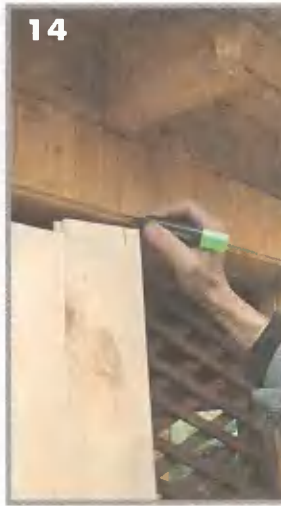
13, 14, 15. Чтобы обеспечить точное сопряжение створок, придется уменьшить щиты по ширине. Для этого найдите средние точки проема (вверху и внизу), перенесите их на заготовки, а затем обрежьте лишние фрагменты
