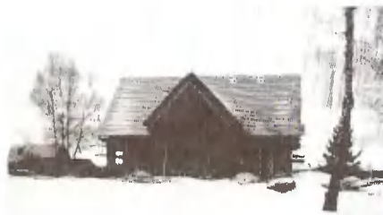
Бревенчатый дом, строящийся зимой
