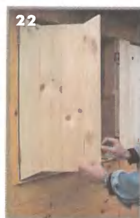
21, 22. Для доработки щита снимите его с простенка и поэлементно обрежьте по отмеченным линиям. По окончании снова соберите щит и, убедившись, что все сделано правильно, окончательно затяните гайки
