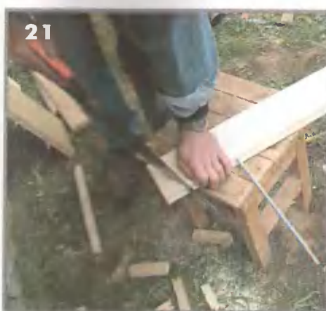
21, 22. Для доработки щита снимите его с простенка и поэлементно обрежьте по отмеченным линиям. По окончании снова соберите щит и, убедившись, что все сделано правильно, окончательно затяните гайки
